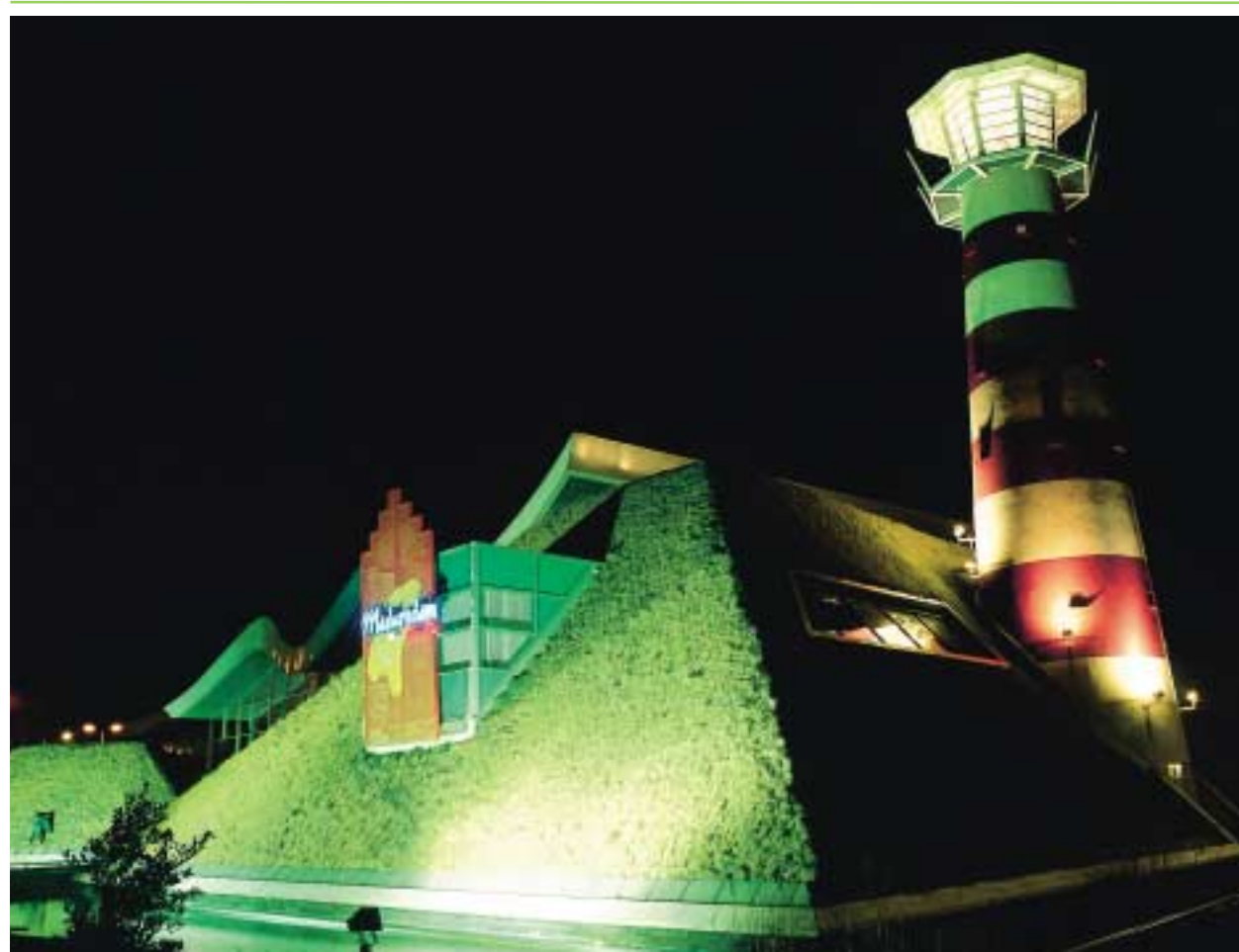
Grasdakhelling van 48° aan de buitenzijde van Madurodam in Den Haag.
